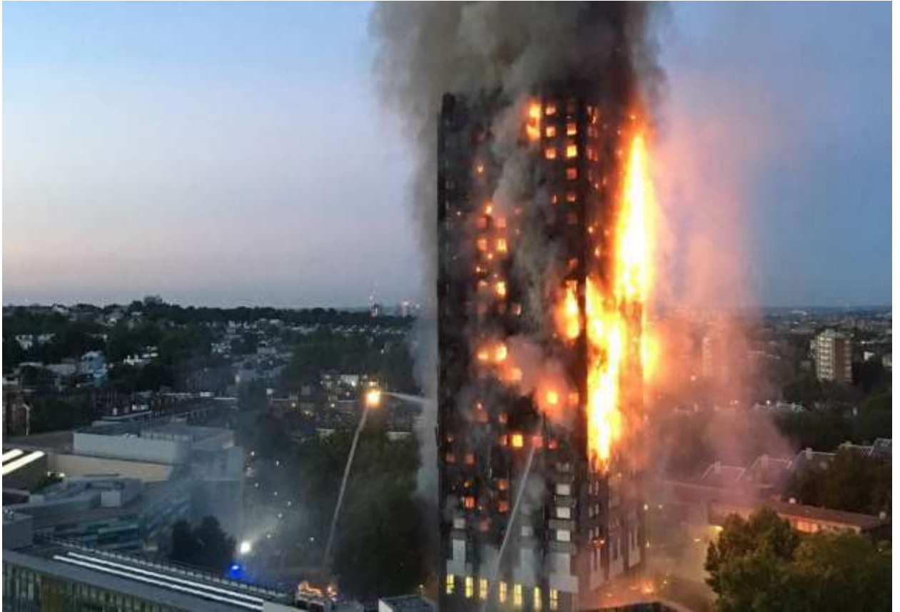
Hình ảnh cháy chung cư Carina Plaza tại thành phố Hồ Chí Minh
